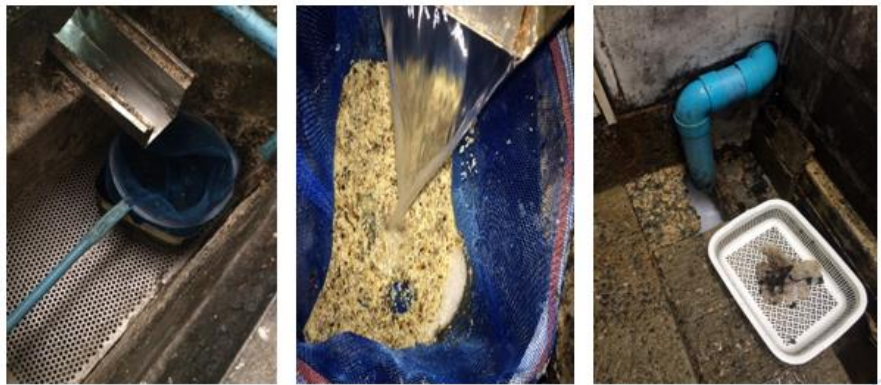
ภาพที่ ๔.๑๒ : การดักเศษ และสิ่งปนเปื้อนขนาดใหญ่จากไลน์การผลิต เพื่อช่วยในการแก้ปัญหาน้ำเสีย ของพนักงานในไลน์การผลิตของโรงงานเจ้าแก้งน้อยฯ ๑๕๗
