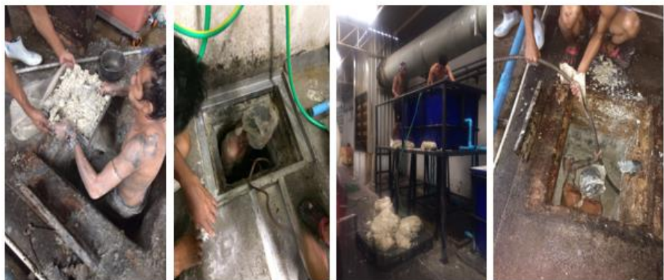
ภาพที่ ๔.๘ : การลอกท่อและบ่อบัก เพื่อให้ น้ำเสียจากอาคารผลิตโหลเวียนสะดวก ๑๕๓
