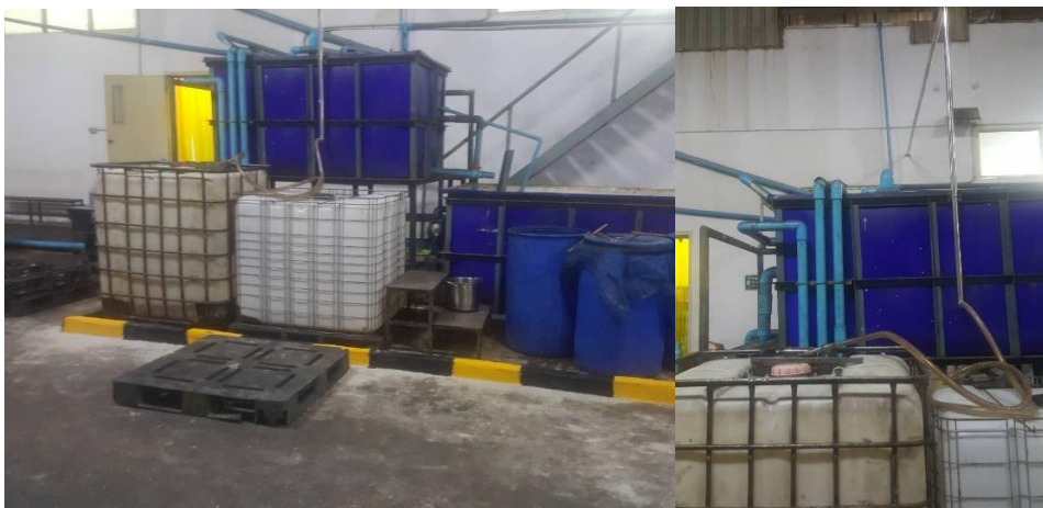
ภาพที่ ๔.๑๗ : การสร้างที่เก็บน้ำมันเก่า เพื่อรอการกำจัดอย่างเหมาะสมจากผู้เชี่ยวชาญ ๑๖๓
